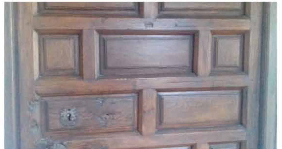
REHABILITACIÓN DE VIVIENDA
